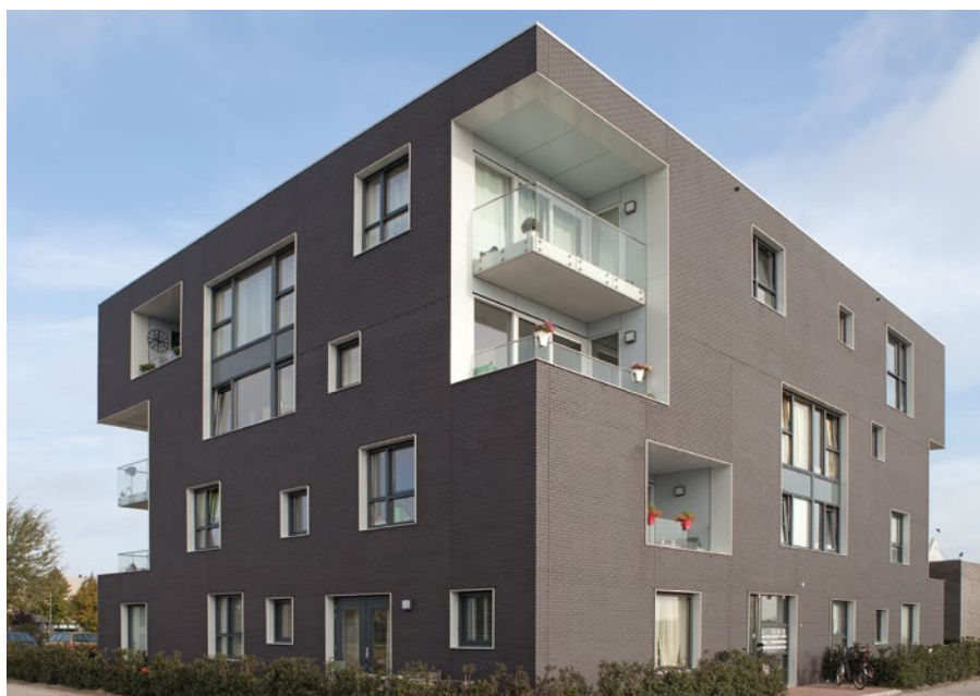
Roval is als totaalleverancier betrokken bij zowel nieuwbouw- als renovatie- en herbestemmingsprojecten
