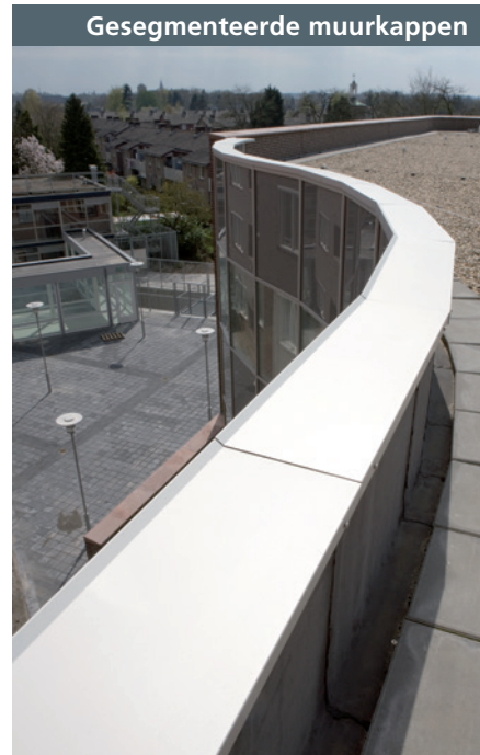
Muurafdeksysteem t.b.v. hellend dak
