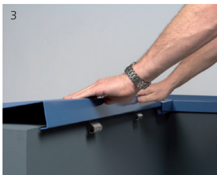
3 De muurafdekkap wordt over de RVS-veer gedrukt.
