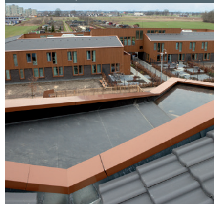
Muurafdeksysteem t.b.v. hellend dak
