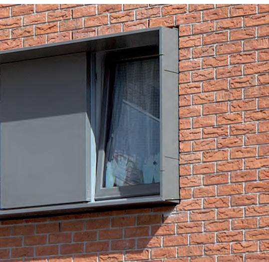
Des logements (encadrements) de fenêtres ne sont pas seulement durable et facile à entretenir, mais en combinaison avec des appuis de fenêtres en aluminium ils forment également une finition esthétique pour façades.
